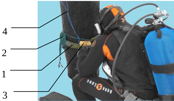
Рис. 20.3. Підривання колоди кільцевим зарядом із пластичної ВР:
